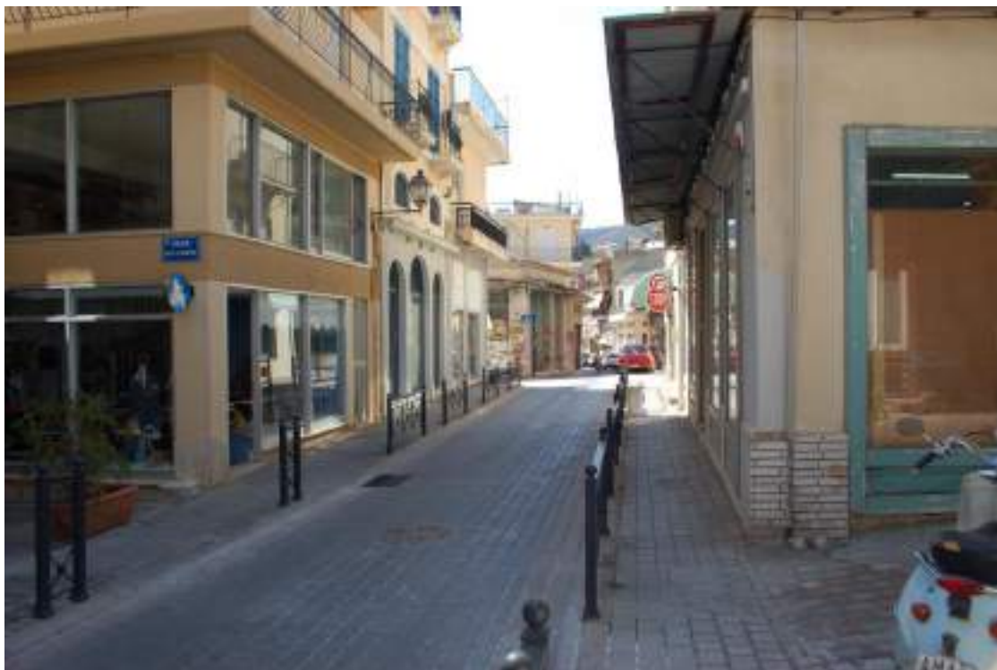
Εικόνα 4.6: Λανθασμένη τοποθέτηση σήμανσης P-2 «STOP» κάτω από P-28 στην οδό Αθαν. Διάκου (Λήψη από Παπούλια προς Ανδρούτσου)
