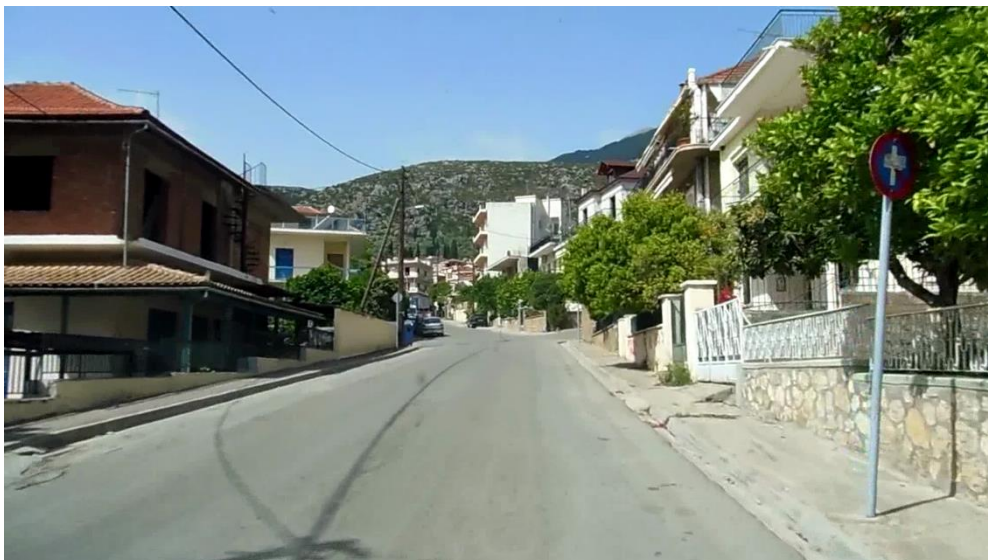
Εικόνα 3.10: Ύπαρξη κατεστραμμένης σήμανσης
