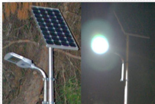
Σχήμα 5.13 : Φωτιστικός λαμπτήρας με φωτοβολταϊκό πλαίσιο
