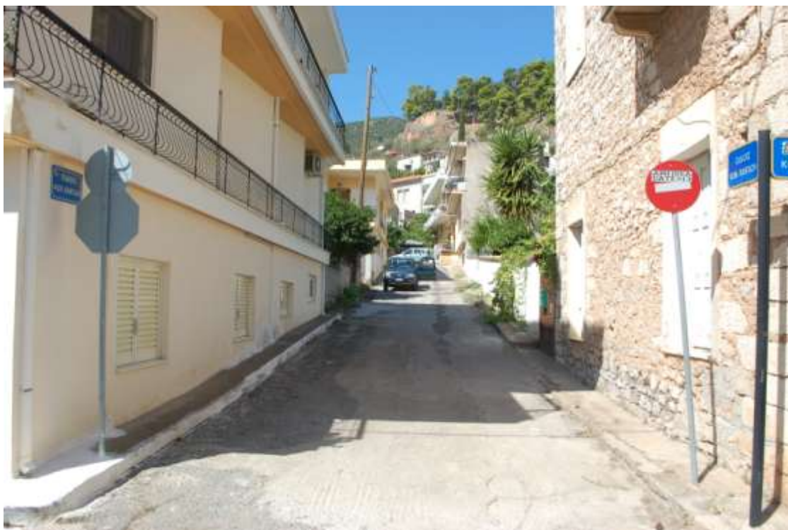
Εικόνα 4.7: Λανθασμένη τοποθέτηση σήμανσης P-2 «STOP» κάτω από P-27 στην οδό Πανταζή (Λήψη από Κοπτορού)
