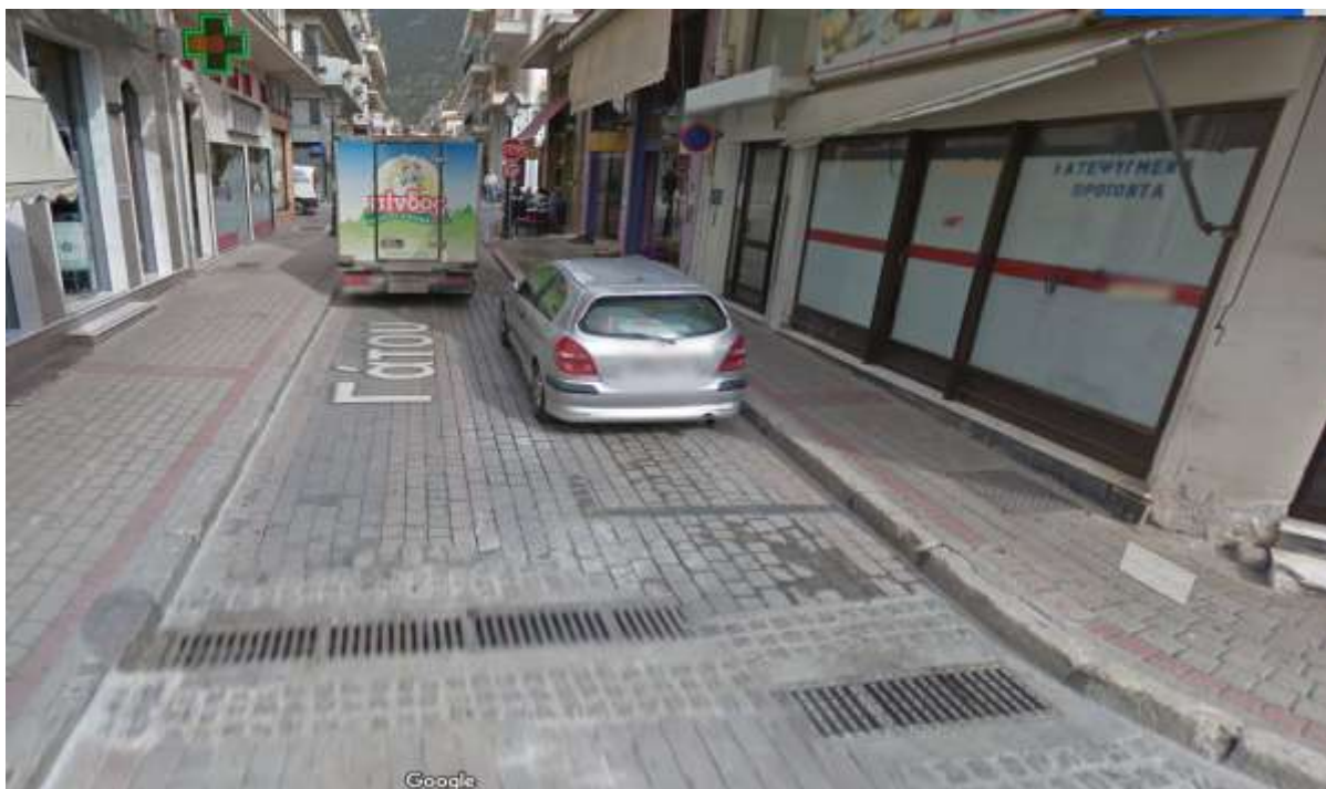
Εικόνα 6.11: Υφιστάμενη απότμηση πεζοδρομίου επί της οδού Ι. Γάτου, μεταξύ Θόαντος & Γιαγτζή
