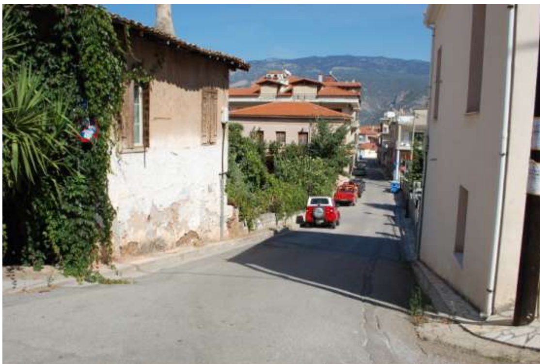
Εικόνα 4.5: Φθαρμένη/ Κρυμμένη σήμανση Ρ-40 στην οδό 41η (Λήψη από Μαχαίρα)
