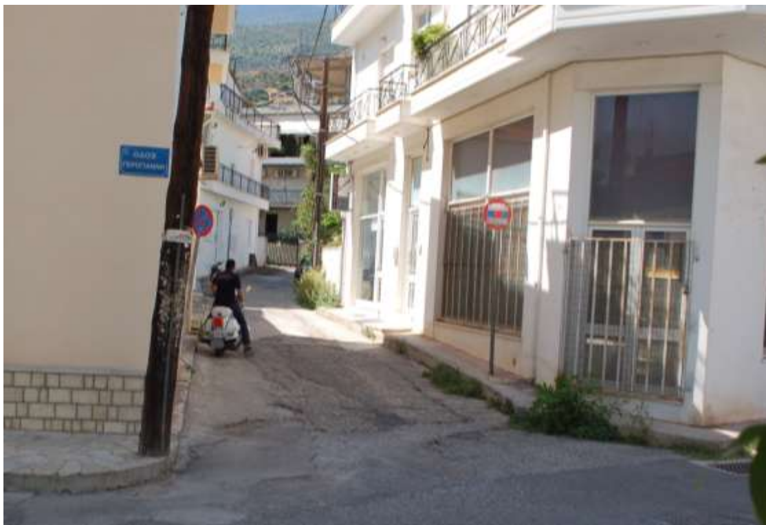
Εικόνα 4.4: Φθαρμένη σήμανση στην οδό Μιχαλοπούλου (Λήψη από Γερογιάννη)
