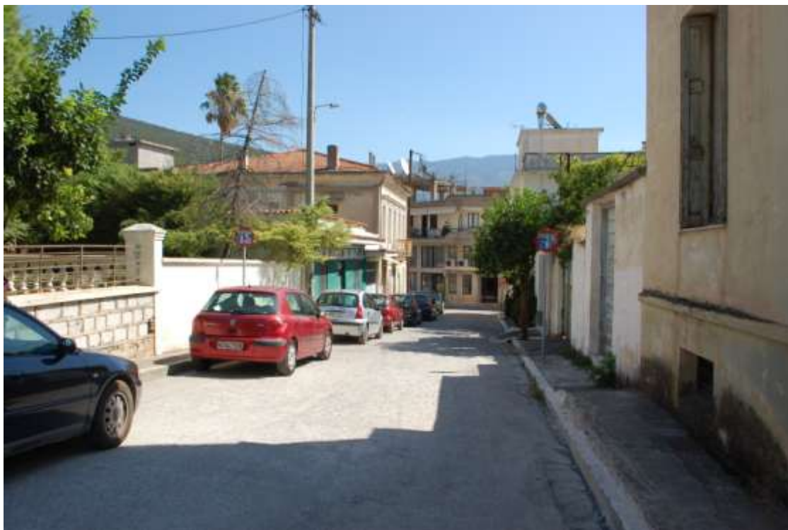
Εικόνα 4.2: P-41 & P-42 στο μέσο της οδού Κόκκαλη
