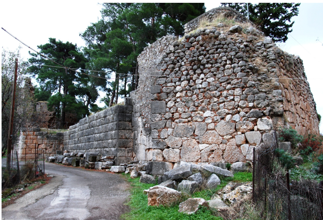
Εικ. 8. Ο προμαχώνας της νοτιοδυτικής γωνίας του πρώτου περιβόλου κατασκευασμένος από πολυγωνικούς λίθους σε δεύτερη χρήση.
