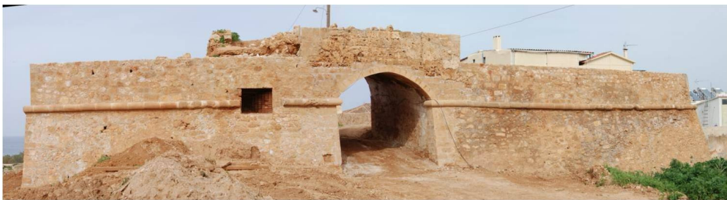
Εικ. 20. Νότια όψη επιπρομαχώνα Santa Katerina μετά τις εργασίες (2012).
