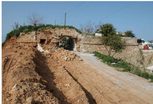
Εικ. 19. Νότια όψη επιπρομαχώνα Santa Katerina πριν από τις εργασίες.
