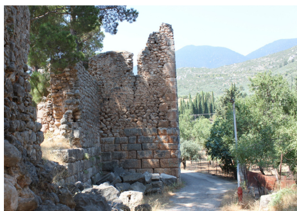
Εικ. 8. Άποψη του ελληνιστικού πύργου που μετασκευάστηκε σε διώροφο κτήριο παρά την είσοδο του Κάστρου, 2012.
