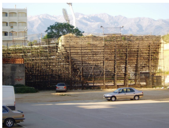
Εικ. 11. Το ακαλαίσθητο λυόμενο θέατρο στην ανατολική τάφρο (1991).
