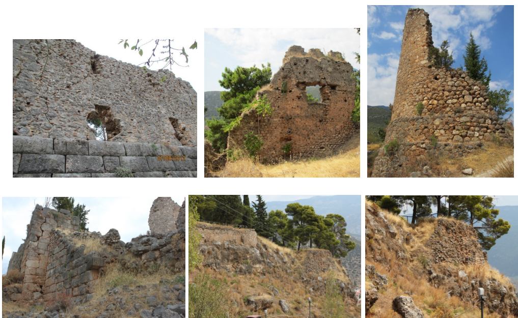
Εικ. 1. Χαρακτηριστικές φθορές και καταρρεύσεις σε τμήματα του Κάστρου.
