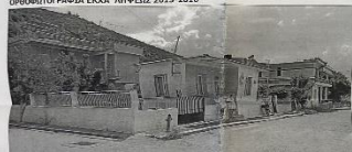
ΦΩΤΟ 1: Η ΠΕΡΙΜΑΝΤΡΩΣΗ ΤΗΣ ΙΔΙΟΚΤΗΣΙΑΣ ΚΑΙ Η ΝΟΤΙΟΔΥΤΙΚΗ ΟΨΗ ΤΗΣ ΙΣΟΓΕΙΟΥ ΚΑΤΟΙΚΙΑΣ
