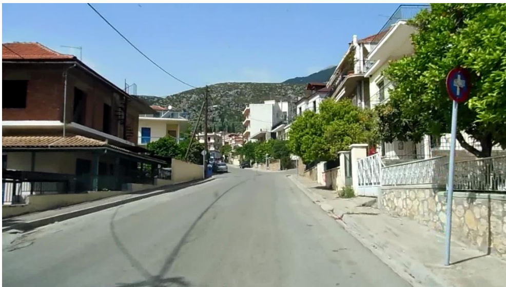
Εικόνα 3.10: Ύπαρξη κατεστραμμένης σήμανσης
