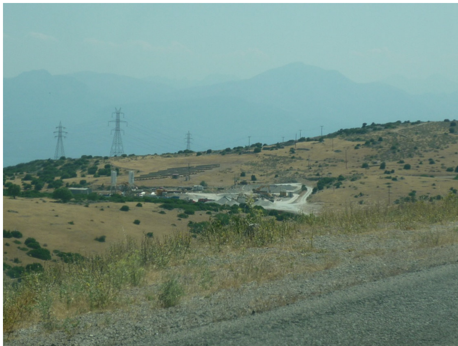
Εικόνα 12: Εργοτάξιο νέας χάραξης Βουνιχώρας-Λιδωρικίου (Αρχείο ομάδας μελέτης)
